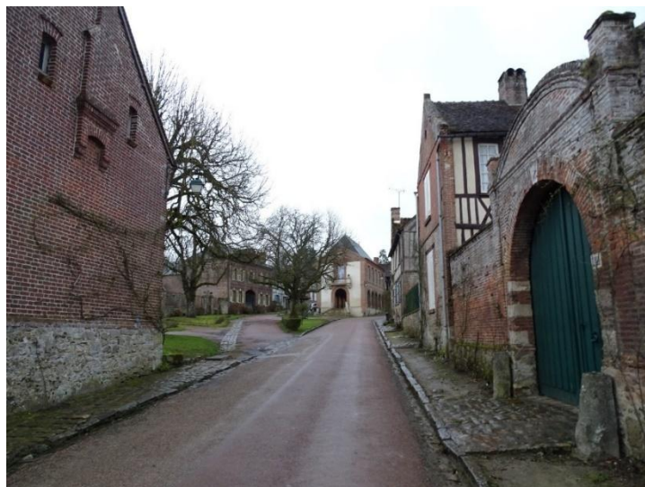
Figure 66 – Place de la mairie à Gerberoy
