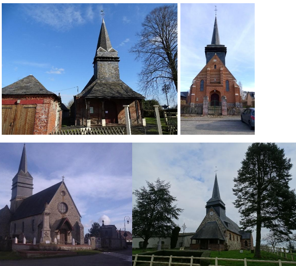
Figure 113 – Eglises d'Abancourt (en haut à gauche), de Briot (en haut à droite), de Senantes (en bas à gauche) et de Rothois (en bas à droite) source : Equipe PLUi
