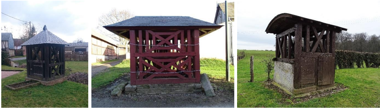
Figure 116 - Puits à Buicourt, Loueuse et St-Maur source : Equipe PLUi
