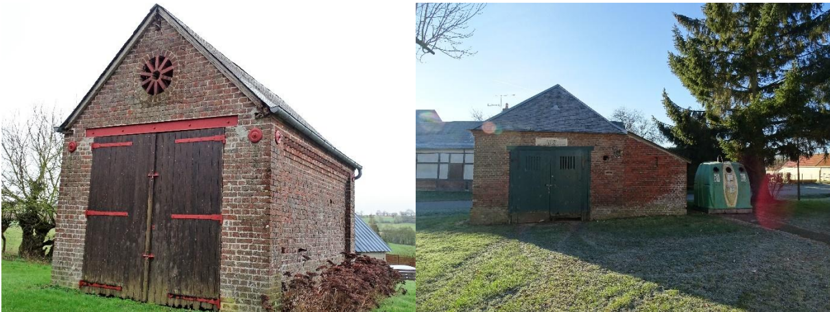
Figure 117 – Bâtiments à pompes à Hécourt et Brombos source : Equipe PLUi
