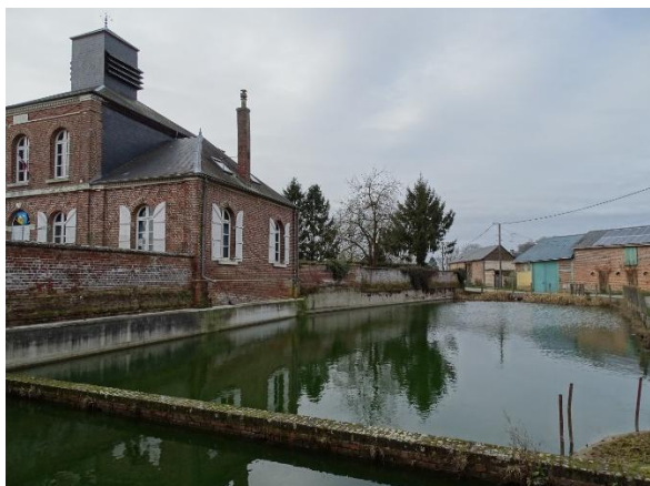
Figure 99 – Mare au droit de la mairie de Grez Source : Equipe PLUi
