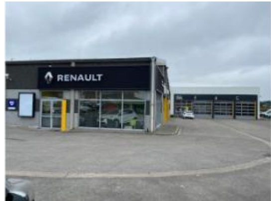
Figure 247 - Garage Renault à Formerie (source : https://www.infovoitureoccasion.com/ville/formerie_60220/ )
